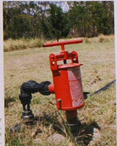
Filtre à tamis, ce type de filtration est indispensable sur les systèmes d'irrigation basse pression (goutte à goutte, microjet...). L'entretien de ce filtre doit être régulier pour éviter l'obstruction des buses.
