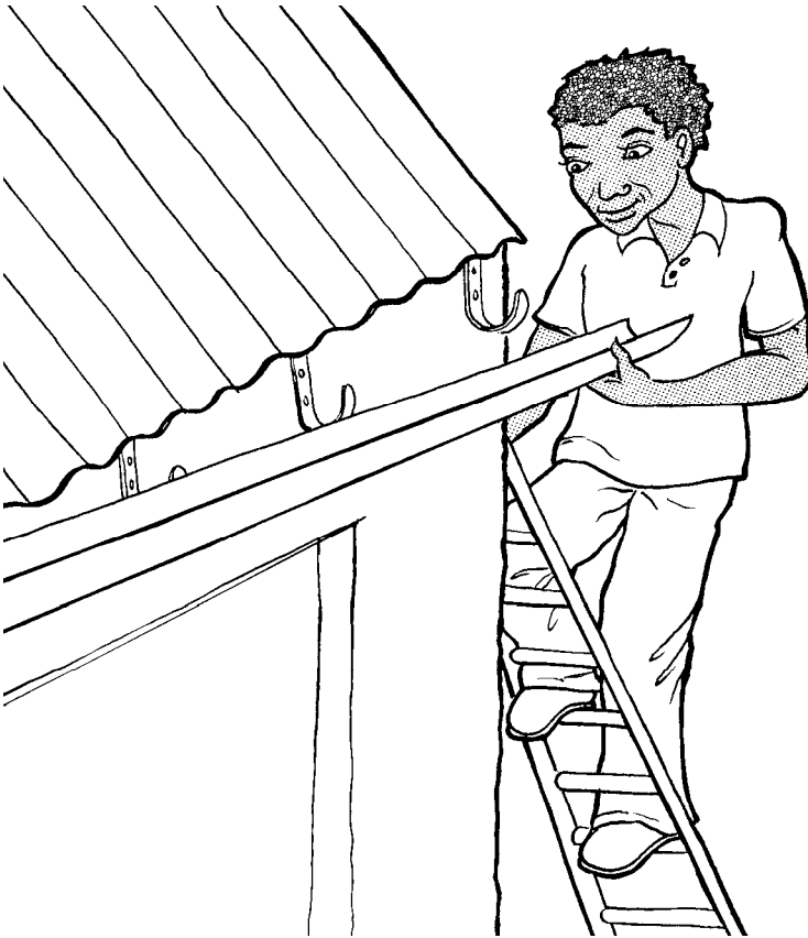
Figure 4 : Installation d'un système de gouttières
