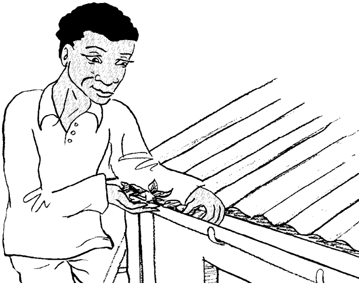
Figure 29 : Retirez régulièrement les débris des gouttières
