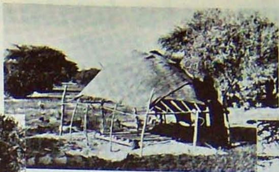
On peut maintenant recouvrir cette structure avec les nattes. La couverture intérieure consiste en deux nattes rectangulaires faites en paille (appelées iwerweren).
