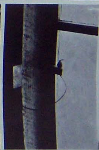
LOQUET SUR UNE FENETRE PIVOTANTE ACCROCHE A UNE LANIÈRE DE CUIR.
