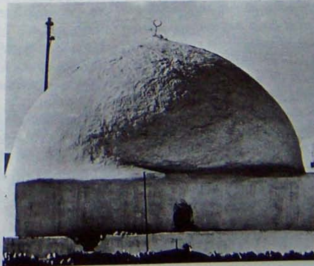
CONSTRUCTION DE STRUCTURES EN FORME DE VOUTE SERVANT AUTREFOIS DE RESERVES A GRAIN AUX TRIBUS NOMADES. ELLES SERVENT AUJOURD'HUI D'HABITATIONS.
