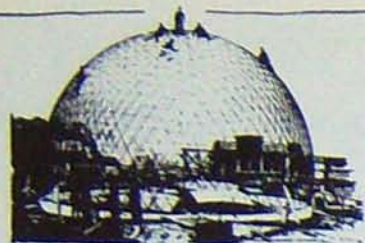
PREMIER DÔME GÉODÉSIQUE 1922
