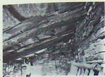
TOIT EN PAILLES DE GRES DE 80 X 150 X 2 FERME EN IRLANDE
