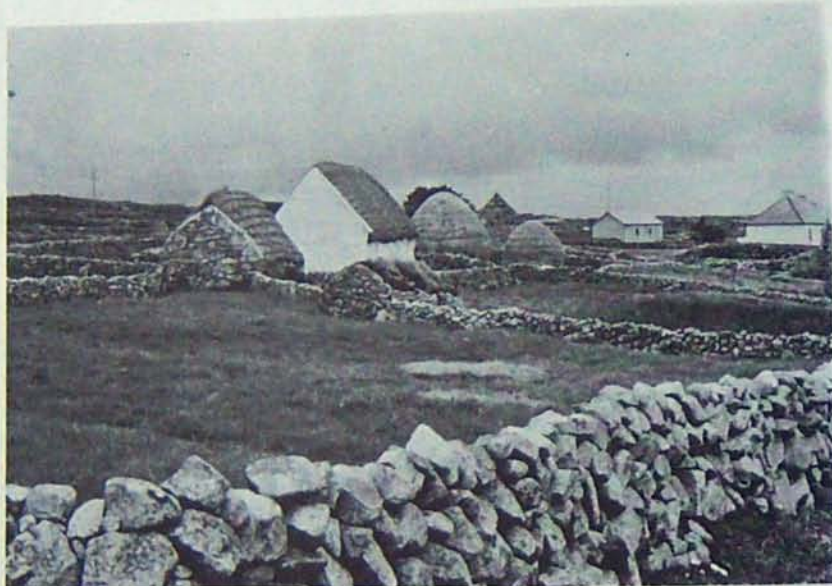
COTTAGES ET BARRIERES CONSTRUITS AVEC LES PIERRES RAMASSEES LORS DU NETTOYAGE DES CHAMPS EN IRLANDE.
