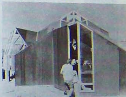
ZOME CONSTRUITA PLACITA (NOUVEAU MEXIQUE CONSTRUIT PAR JOHN MARTIN)
