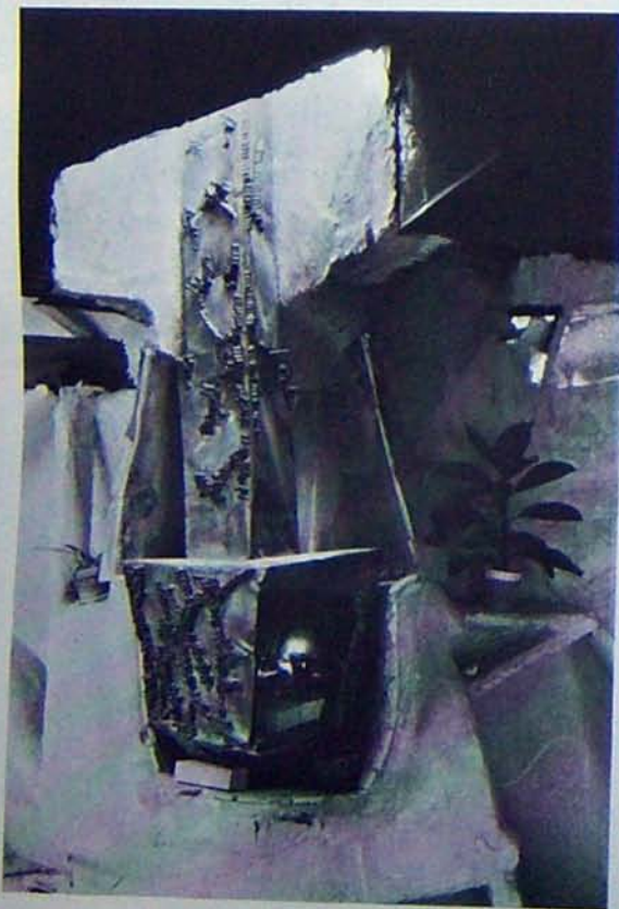
UNE ENTRAIT REALISE AVEC DES JANTES DE ROUE D'UNE PORTEE DE 4,50M, DES TUYAUX DE 5CM DE Ø SONT SOUDÉS EN BAS ET EN HAUT
