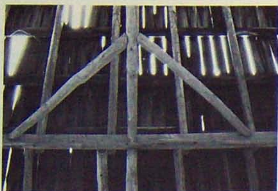
GRANGE DATAIT D'UNE CENTAINE D'ANNEES PRES DE SANTA ROSA. LES PLANTS DE SEQUOIA SONT CLOUES ENSEMBLE. LES SEMELLES DE COMBLE SONT DOLÉES A LA BASE ET AU SOMMET MAIS LES PERCHES ET LES ENTRETOISSES SONT ENTIERES.
