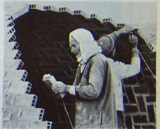
CONSTRUCTION DE STRUCTURES EN FORME DE VOUTE SERVANT AUTREFOIS DE RESERVES A GRAIN AUX TRIBUS NOMADES. ELLES SERVENT AUJOURD'HUI D'HABITATIONS.
