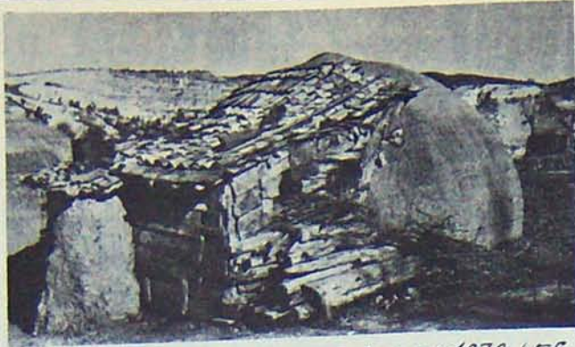
TREMBLEMENT DE TERRE AU PEROU EN 1970. LES DÔMES DE MOUSSE RECOUVRENT LES ÉLÉMENTS CONSTRUITS À LA MAIN
