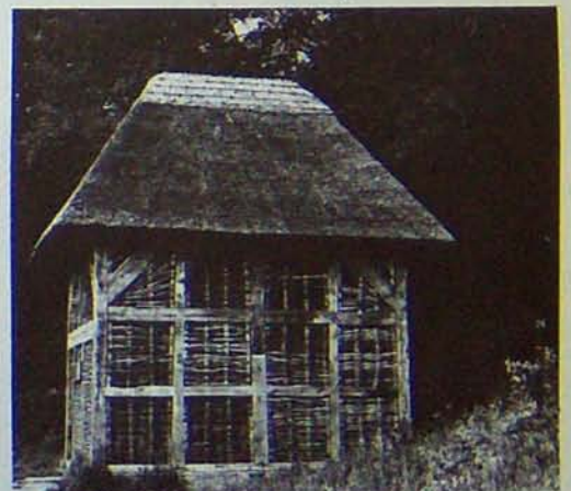
MAISON COUSSUE, CHARPENTE RECONSTRUITE D'APRES LE MODELE DE 1600, MUSEE EN PLEIN AIR DE WEALD, SUSSEX.
