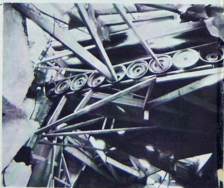
UNE ENTRAIT REALISE AVEC DES JANTES DE ROUE D'UNE PORTEE DE 4,50M, DES TUYAUX DE 5CM DE Ø SONT SOUDÉS EN BAS ET EN HAUT
