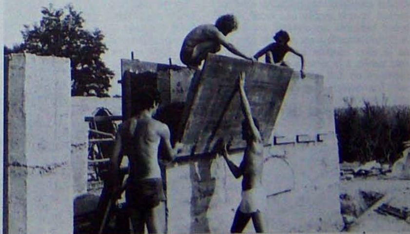
DEMONTAGE DE LA BANCHE
