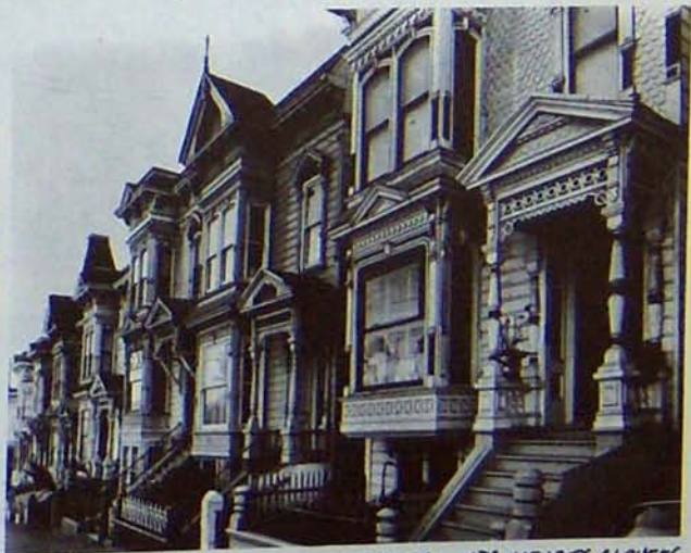
MAISONS VICTORIENNES A SAN FRANCISCO. STRUCTURES CLOUÉES
