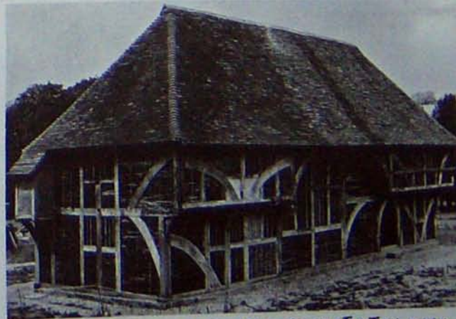
FERME A CLAIRES-VOIES, EN COURS DE RECONSTRUCTION, DATE D'ORIGINE 1450. MUSEE EN PLEIN AIR DE WEALD SUSSEX
