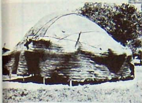
Elle est recouverte à son tour de nattes ovales (isfal) retenues sur la voûte par un ensemble de cordages et de longues nattes (asalemamas) faisant office de murs attachés à la structure en bois; toutes ces nattes sont faites à partir de feuilles de palmier.
