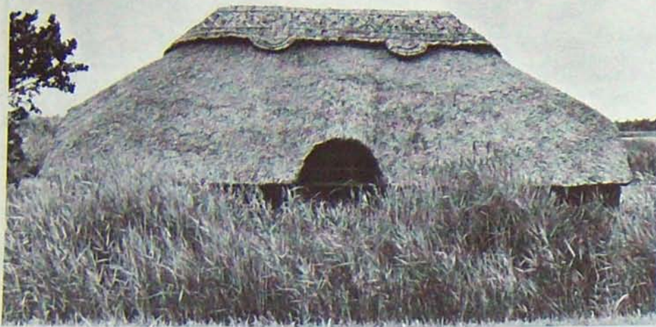
TOIT EN ROSEAU DU NORFOLK SUR UN HANGAR A BATEAUX, NORFOLK, ANGLETERRE
