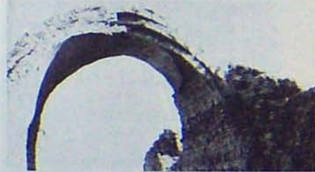
VOûTE EN BRIQUES D'ADobe, MONASTERE EGYPTIEN PRES D'ASSIEN (1890 AVANT JC)
