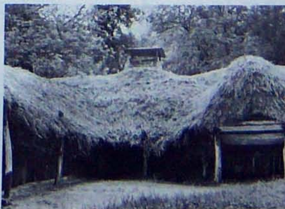
MAISON DES CARPATHES - LA FUMEE S'ECHAPPE AU TRAVERS DU CHAUME
