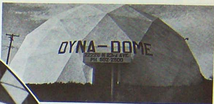
DYNA, DOME D'ÉGLISE DE 24 m DE Ø CONSTRUIT PAR LES PAROISSIENS MONTANTS DE 5 X 10 COUVERTURE EN CONTRE-PLAQUE (PHOTO J. DAMINIS)
