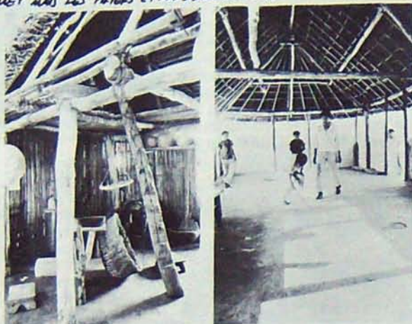
GRANGE DATAIT D'UNE CENTAINE D'ANNEES PRES DE SANTA ROSA. LES PLANTS DE SEQUOIA SONT CLOUES ENSEMBLE. LES SEMELLES DE COMBLE SONT DOLÉES A LA BASE ET AU SOMMET MAIS LES PERCHES ET LES ENTRETOISSES SONT ENTIERES.
