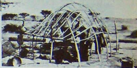
On démonte la tente pour aller la remonter dans un autre endroit. La femme qu'on voit à l'intérieur de la structure défait les boucles retenant les demi-arceaux fixés aux grands arceaux centraux. Cette tente, de même que celle au-dessus, appartient aux Imezzuregs, tribu vivant dans l'Ayr du Sud, près d'Agadès.
