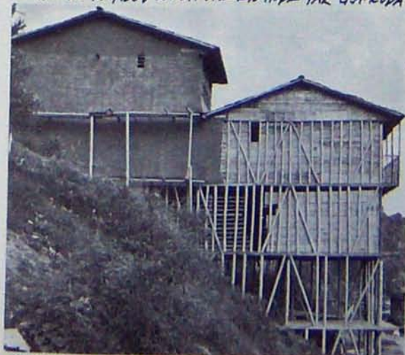
STRUCTURE DE BAMBOU RECOUVERTE DE PLATRE COLOMBIE
