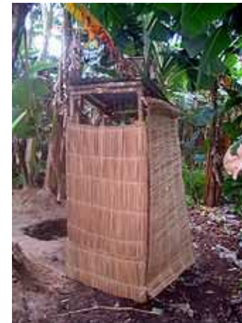
Une superstructure d'Arborloo facilement déplaçable.
