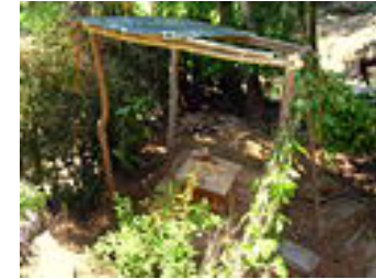
Superstructure en bois et en tôles
