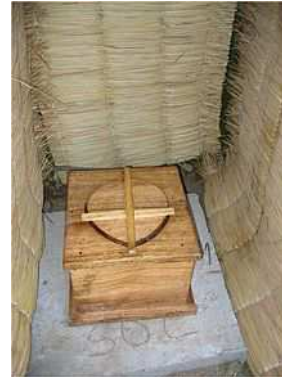
Vue de l'intérieur d'un Arborloo avec une dalle en béton transportable, un siège en bois et des parois en paille.
