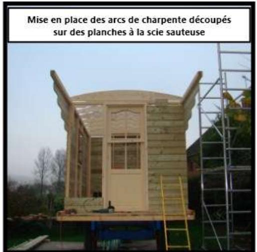
Mise en place des arcs de charpente découpés sur des planches à la scie sauteuse
