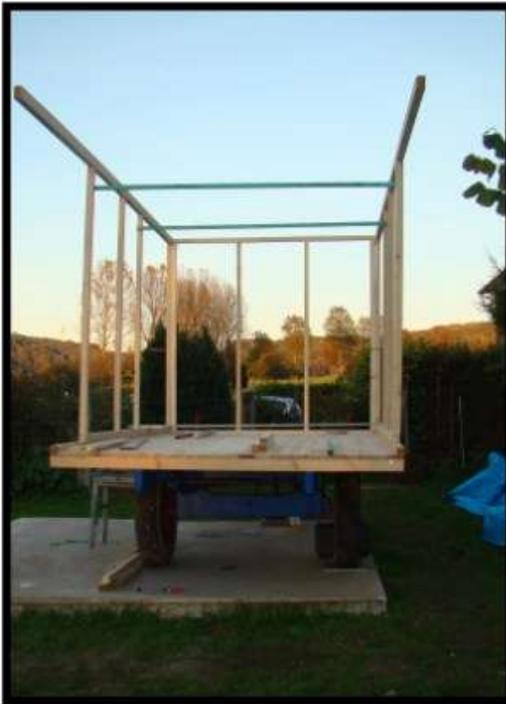
Après pré-assemblage au sol des 4 pans de l'ossature, Montage de ces derniers directement sur le plateau (à l'aide de tire-fonds) afin de constituer les supports des 4 murs de la roulotte.
